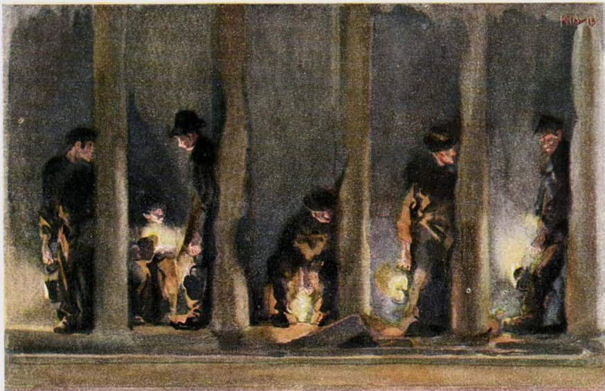
Tunnelarbeiter beim Sprengen
